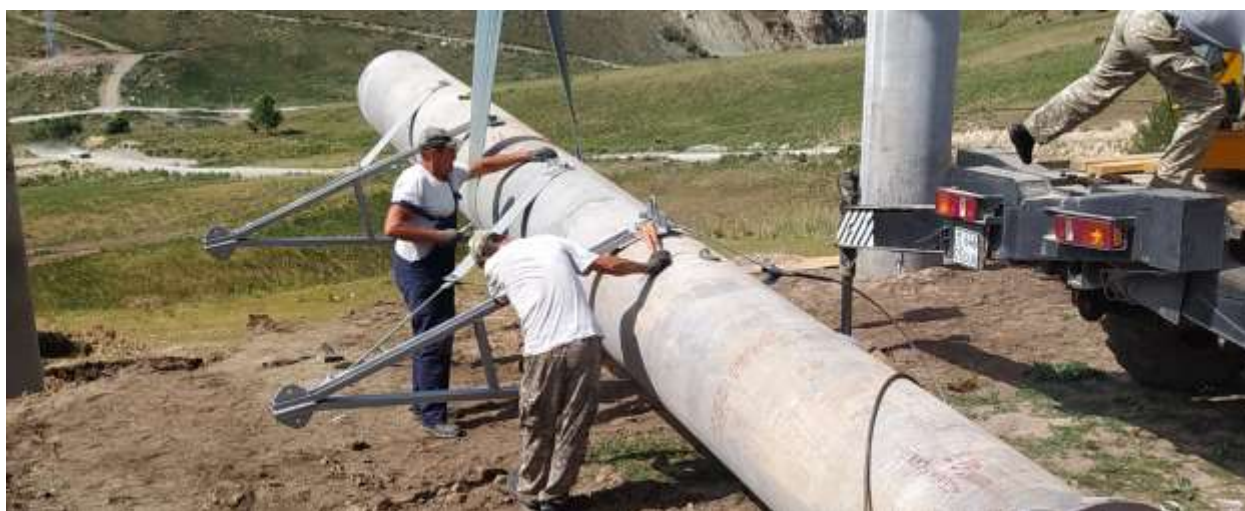
Рисунок 5 - Сборка траверс
