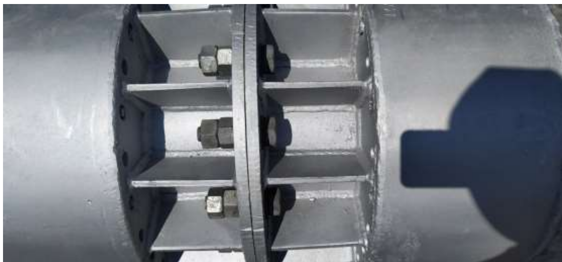
Рисунок 4 - Процесс сборки нижней и верхней части опоры
