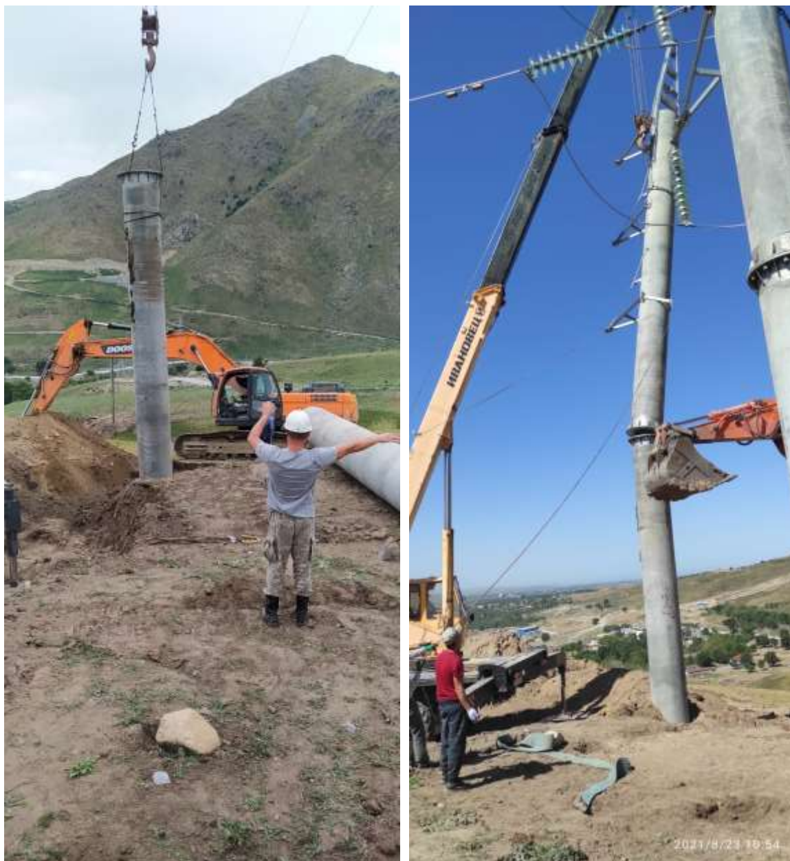
Рисунок 8 – Установка опоры
